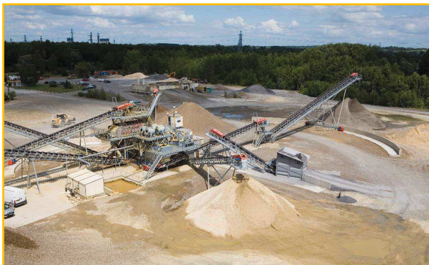
Les installations du site de La Frette : un exemple d'outil industriel de dernière génération. (Photo M. DELETANG)
